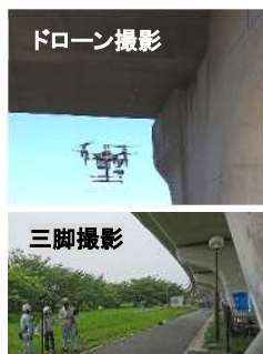
ひび割れ撮影
